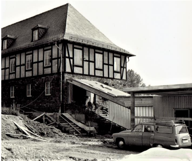
Am 1. September 1975 konnte das neue Gebäude mit vollständiger Innenausstattung übergeben werden.
